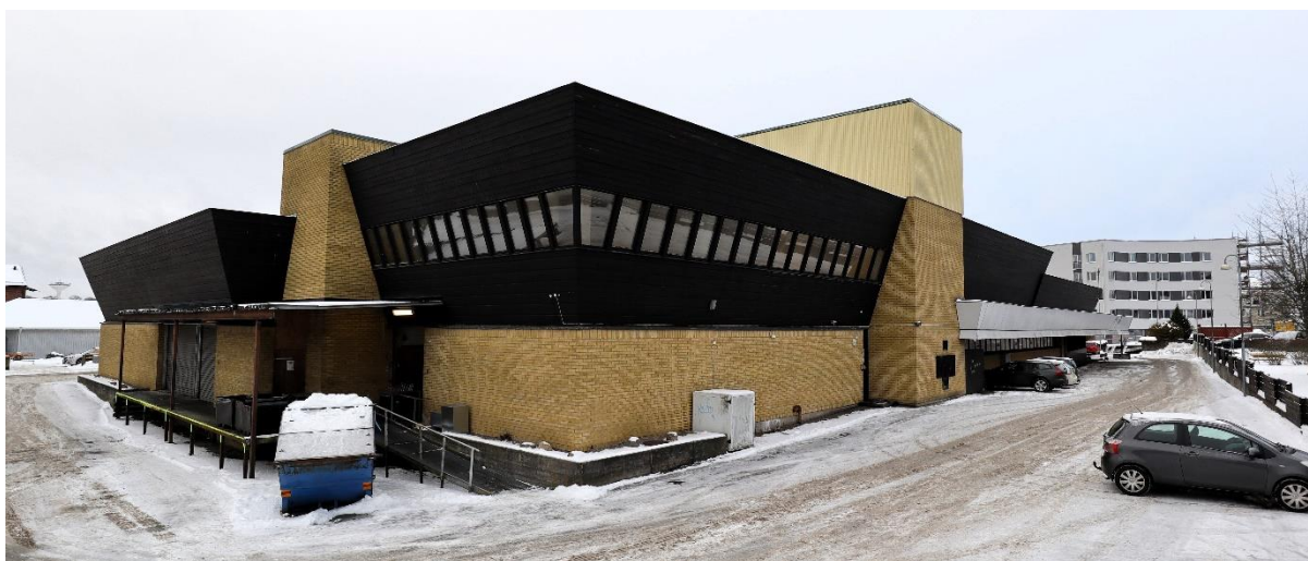
Det arkitektoniskt märkvärdiga nordvästra hörnet påminner närmast om ett flygledartorn. Innanför fönsterraden ligger personalutrymmen. Exteriören är i stort sett helt autentisk. Något förvånande skapade arkitekten byggnadens mest spektakulära del på baksidan.
