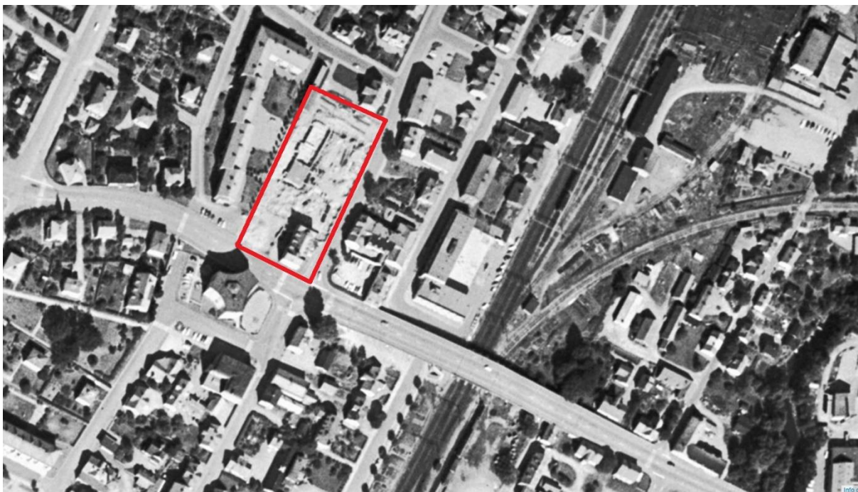
Pågående rivningar i kvarteret Hjorten inför varuhusbygget. Viadukten som färdigställdes 1958 över stambanan fick stor betydelse för köpingens utveckling. Lantmäteriet.
